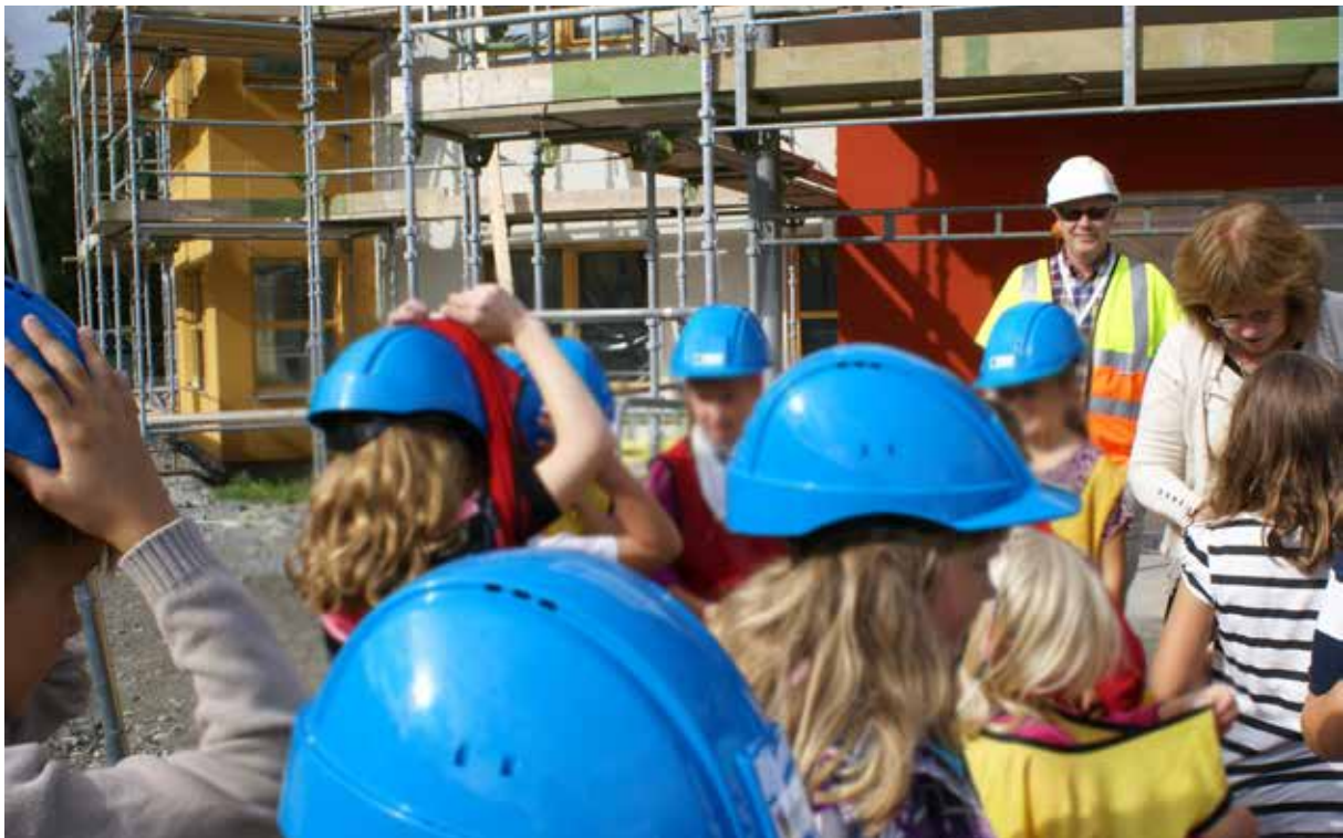
Elever från Bollstanässkolan inspekterar byggandet av sin nya skola
