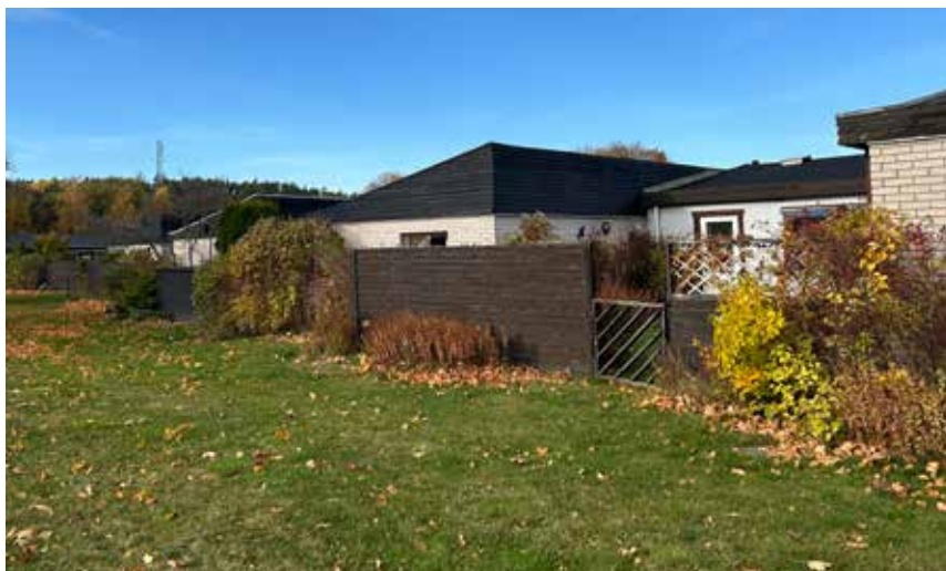
Vinklehusen är ihopbyggda så att en atriumgård skapas på baksidan. Den privata gården avgränsas av höga mörkt målade plank mot den allmänna parkytan. Husen upplevs landa direkt på den klippta gräsmattan och gränsen mellan privata och gemensamma ytor är tydlig.
