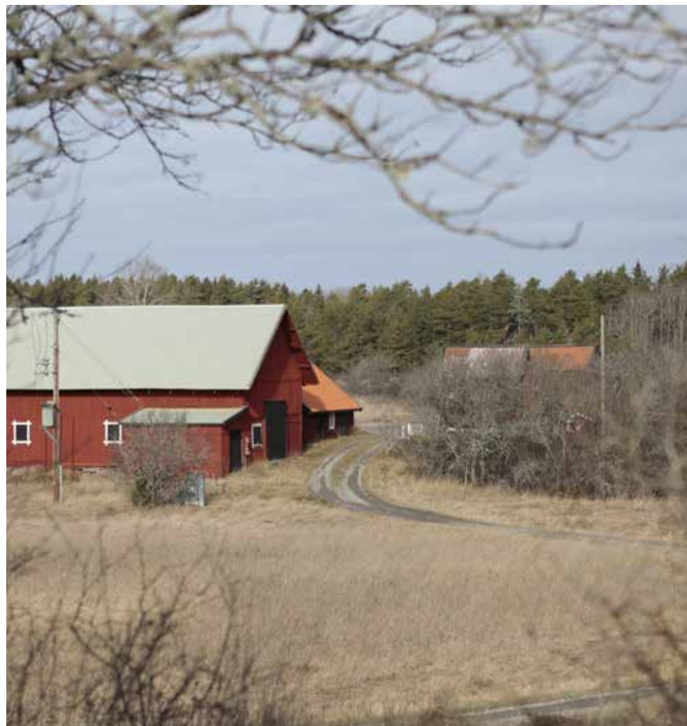
Dyvinge är en ensam gård med en handfull byggnader och har en väl bevarad 1800-talskaraktär. Foto: Teodor Mattsson
