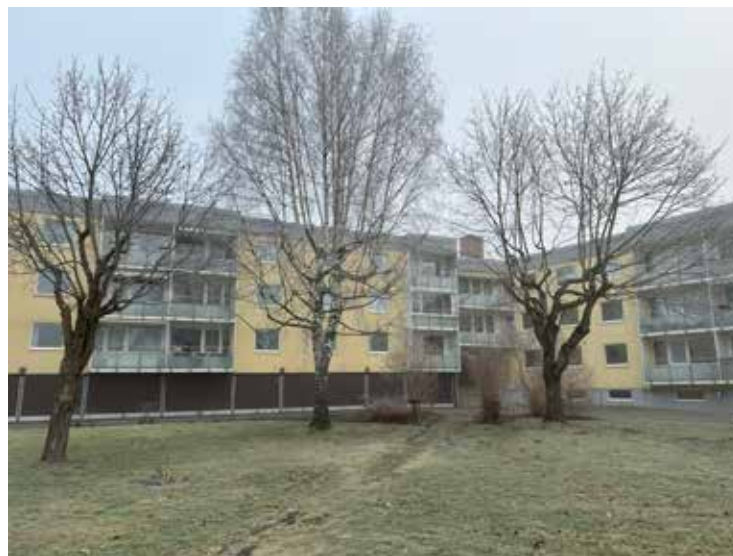
Vinkelbyggt kvarter i gul puts och utbytta balkongfronter.
