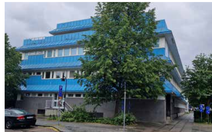
Vårdcentralen har en fasadutformning i utragande klarblå bandtäckt plåt.
