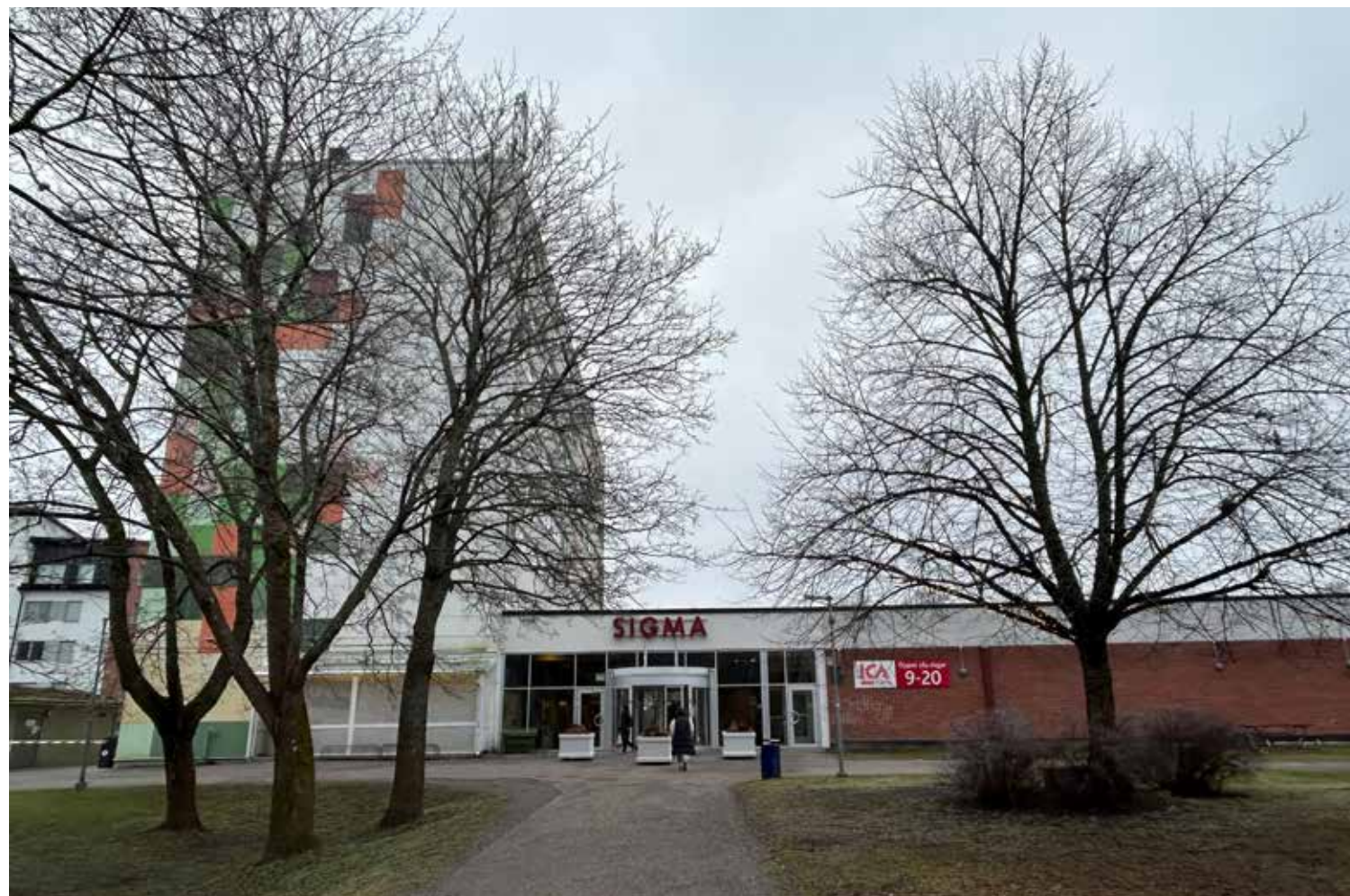
Sigma centrum, typiskt modernistiskt sammanbyggd lågdel och högdel med gavel som annonserar centrum mot parken. Genom hela kvarteret går sammankopplande gångstråk från bostadsgårdarna genom parken fram till centrum.
