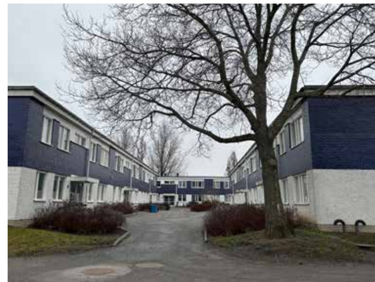
Entréerna ligger vända mot en gemensam entrésida.
