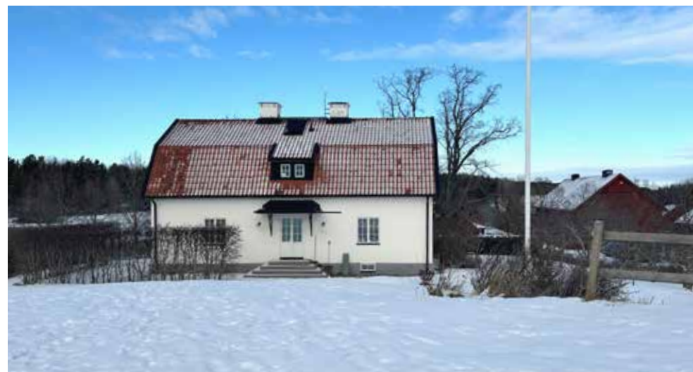
Huvudbyggnaden vid Stjärnborg. I dalen nedanför har ett flertal stall och ridhus uppförts under 2000-talet.
