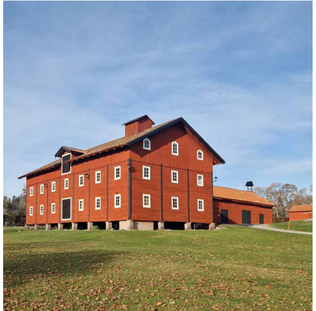
Ekonomibyggnader vid Antuna, det stora magasinet med vällingklocka är framträdande i landskapet.
