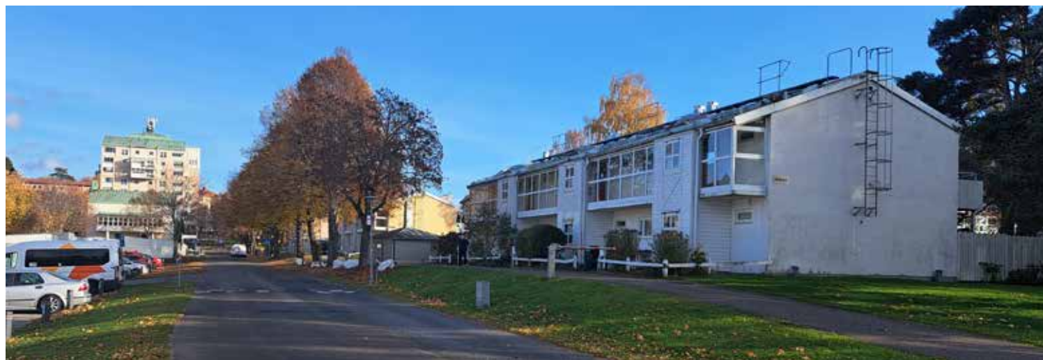
Området är trafikseparerat och angörs via en matargata i ring runt området. Till höger ombyggda äldre personalbostäder som försetts med utanpåliggande trapphus och inglasade loftgångar. Centrumhuset utgör en solitär i fonden av gatan som kantas av en av oxelrad.
