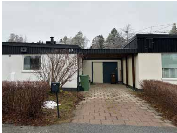
Taklandskapet i olika vinklar förstärks av träpanelens mörka kulör.
