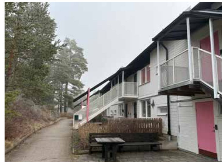
Bostadsentréer via trapplopp med tak mot bostadsgården.
