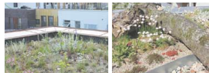
Takplantering av Veg Tech vid Koggen 1, Malmö. Byggår 2014
