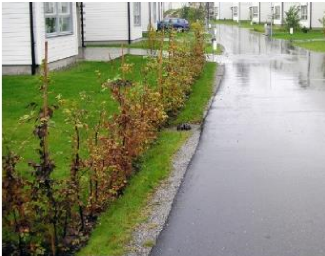
Figur 6-4. Till vänster om vägen finns ett underliggande makadamdike som har en häck planterad ovanpå. I det översta lagret blandas mindre fraktioner makadam med jord och i botten placeras grövre makadamfraktioner.
